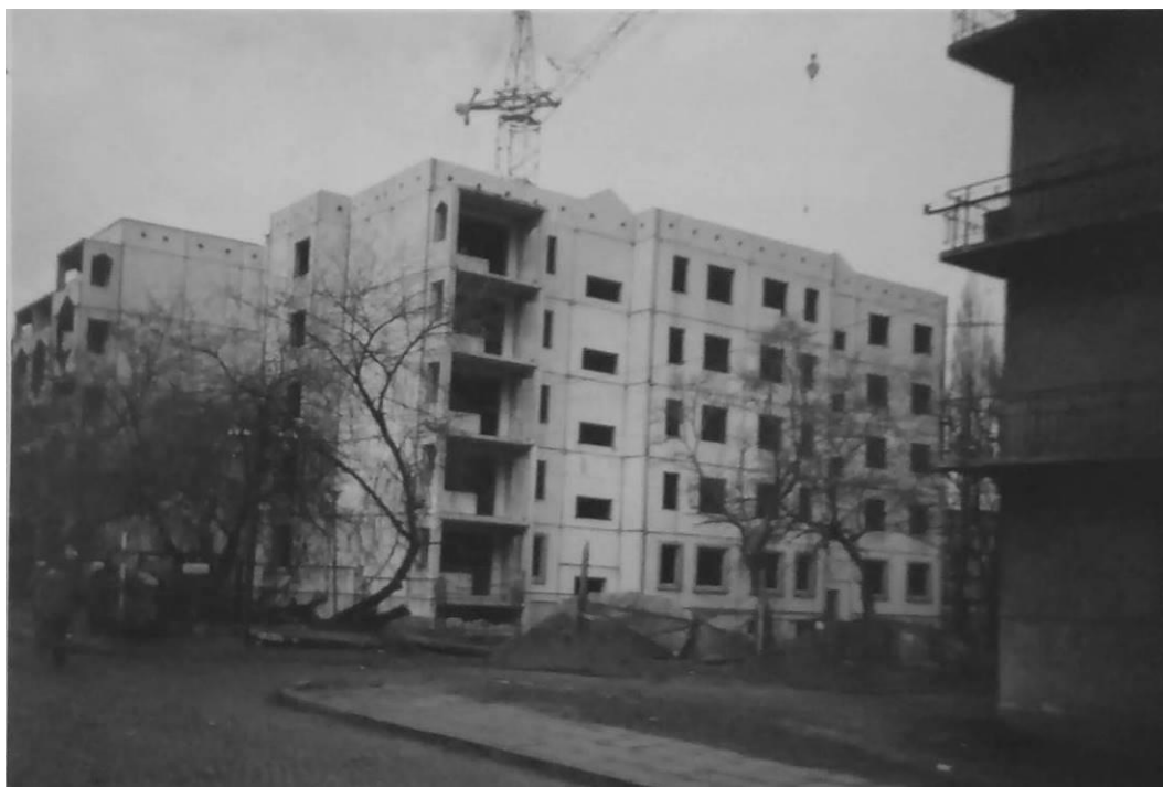
Fot. 17 Stan budowy bloków dla nauczycieli z roku 1991
